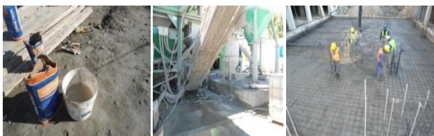
Figure 2.2.1.1: a); b);c);d) Concrete production site
